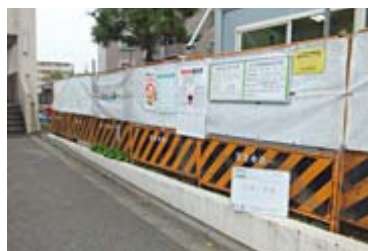
▲現場事務所設置
