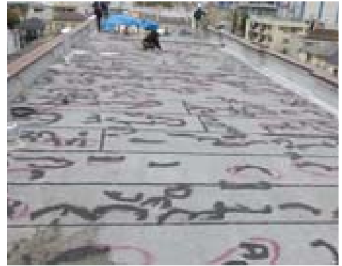
▲既存防水層補修状況
