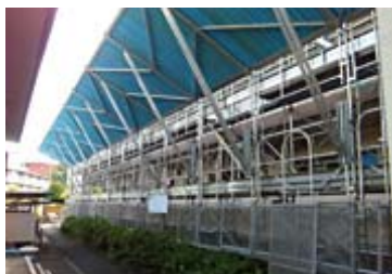
▲足場架け (朝顔設置)
