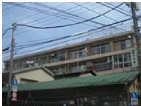
施工前 施工中
