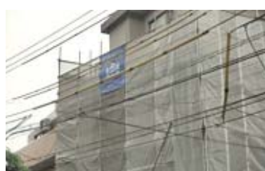
仮設足場設置後
