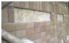
▲タイル張り替え
